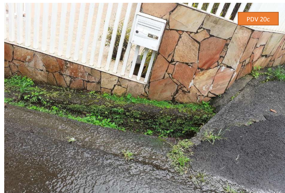
Figure 20 : Exemples d'aménagements (fossés, grilles de récupération) au lieu-dit Durand, à l'approche de l'UPEP
