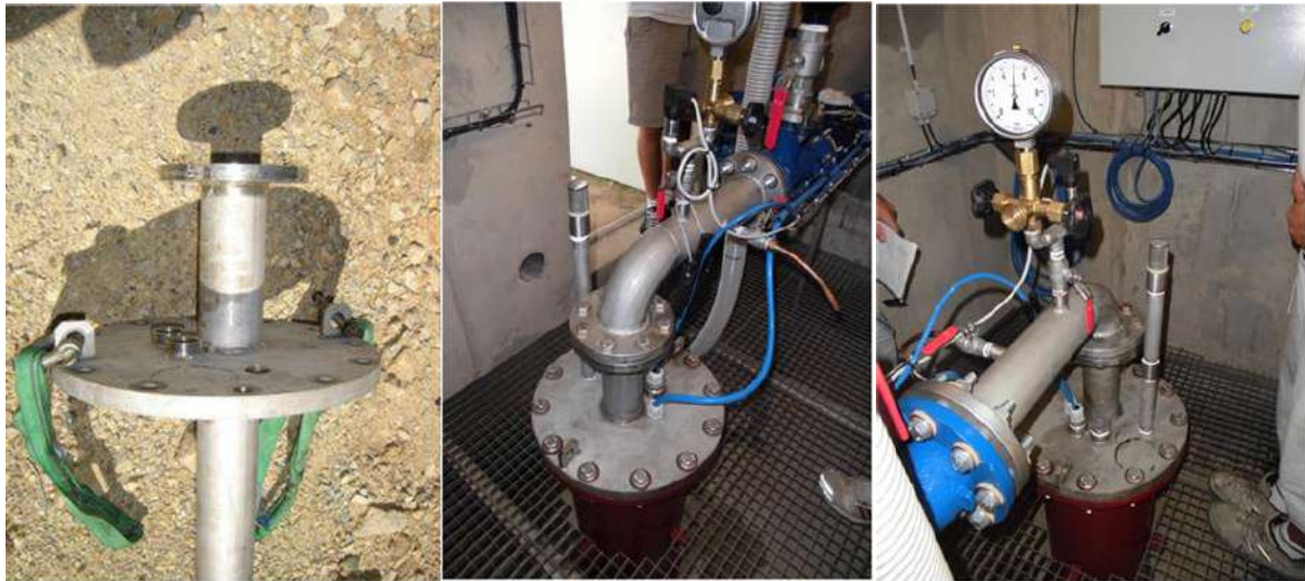
Figure 68 : Exemples de dispositif de protection au niveau des têtes de forages (Source : SAFEGE © Enrico PEGNA)
