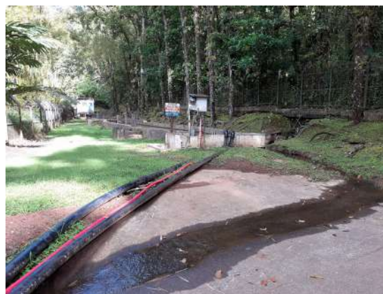
Vue du dessableur et des conduites de refoulement des forages installées en 2020
