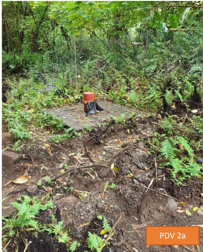
Figure 2 : Forage 1 non raccordé et câblage existant jusqu'au dessableur
