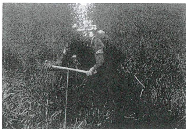
Vissage à la main d'une ancre dans les posidonies
