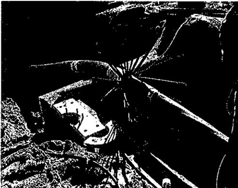
FIGURE 7 : EXEMPLE DE JONCTION DU CÂBLE SOUS MARIN ET SOUTERRAIN DANS UNE CHAMBRE D'ATTERRAGE
