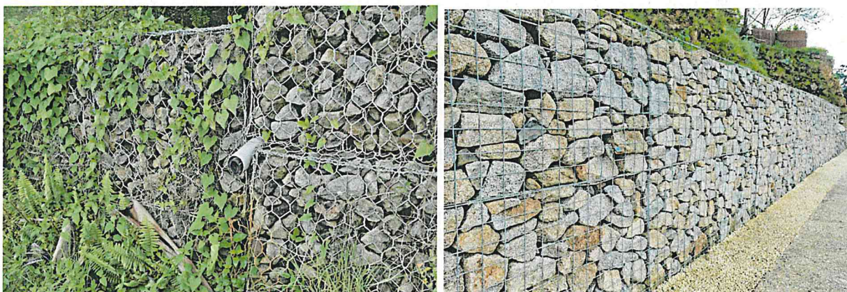
Gabion avec drain sur le site
