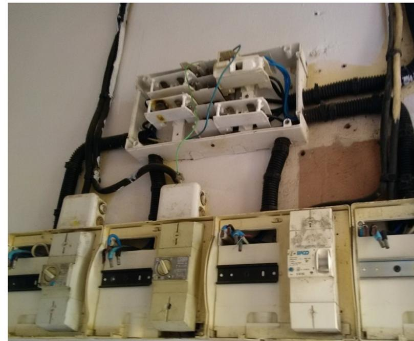
**Réseau électrique non conforme**
