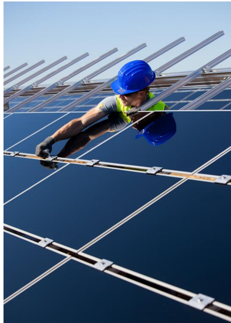
Remplacement de module (crédit photo EDF Renewables)
