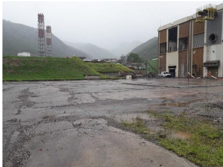
Site retenu pour l'implantation d'un parc photovoltaïque à Bellefontaine (crédit photo : SUEZ CONSULTING)
