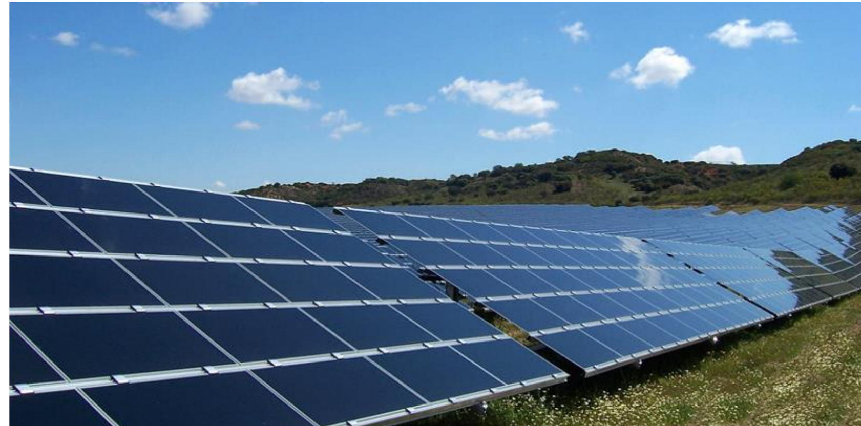
Parc photovoltaïque EDF Renewables de Narbonne
