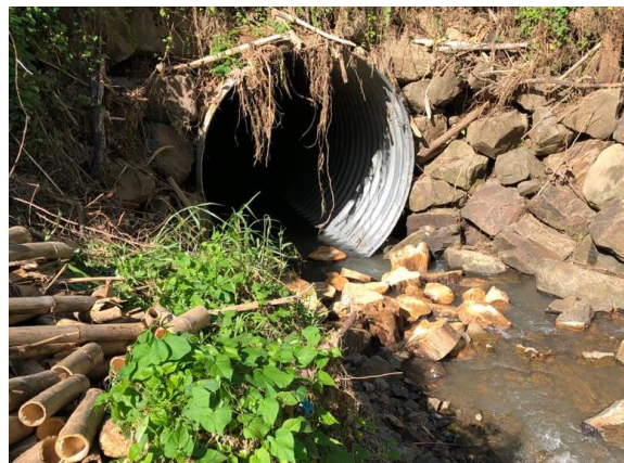
Création de l'ouvrage 5 – accès site industriel, gestion de crue et des embâcles.
