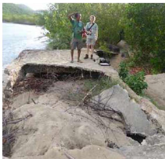
Pont en démolition
