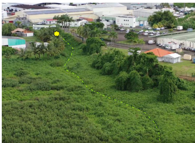
Figure 23 : Point de rejet et axe d'écoulement – Photo aérienne (source : Antea Group)
