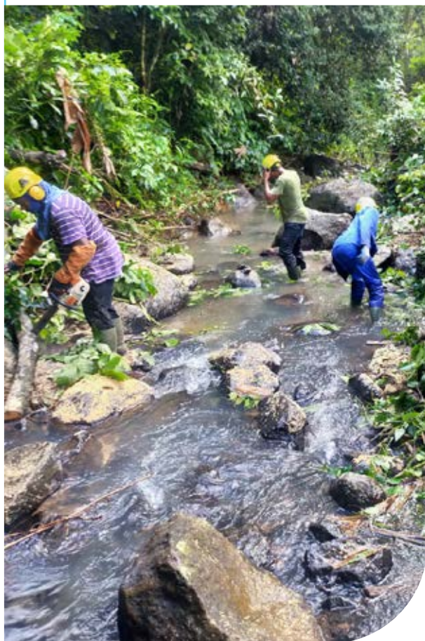
Travaux d'élagage - Rivière Jambette © DEAL 972
