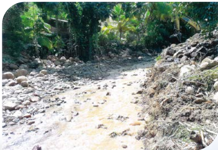
Après travaux - Rivière Fond Saint Jacques - Sainte-Marie © DEAL 972
