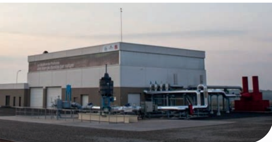
Centrale géothermique (photomontage) - Lamentin © ADEME
