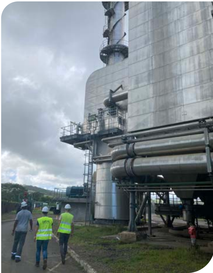
Visite d'inspection ICPE Albomia © DEAL 972
