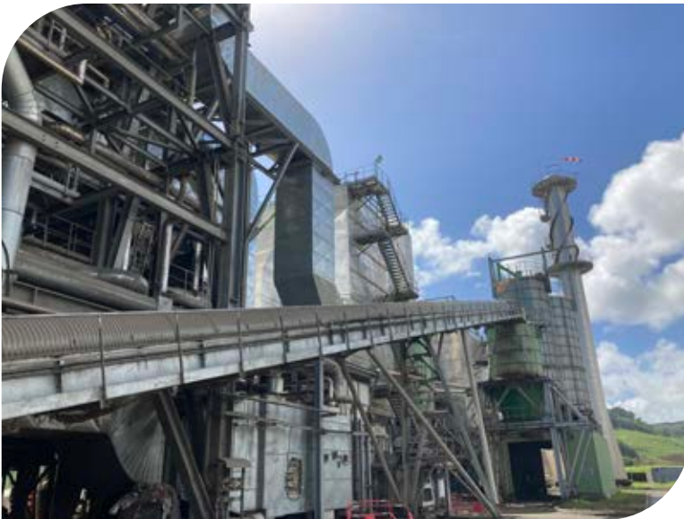
Visite d'inspection ICPE Albomia © DEAL 972
