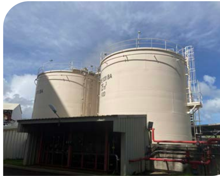
Visite d'inspection ICPE Albomia © DEAL 972
