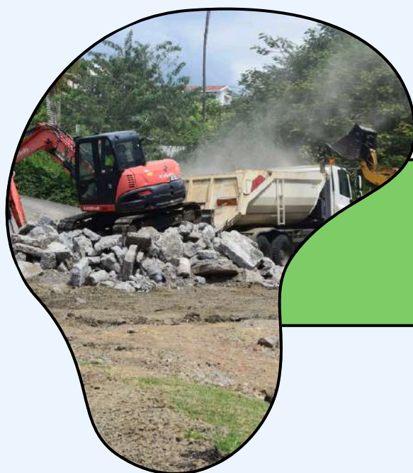
* Travaux de désimperméabilisation : enlèvement des terrains de tennis
