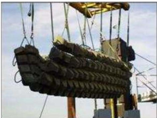
Exemple d'un matelas béton (Source : données 2013, RTE)
