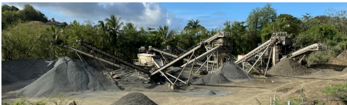
Figure 2. Installations de traitement (SMDG, juin 2023)
