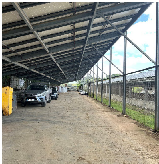
Figure 8: Hangar de l'exploitant Ferme Eco Pilote
