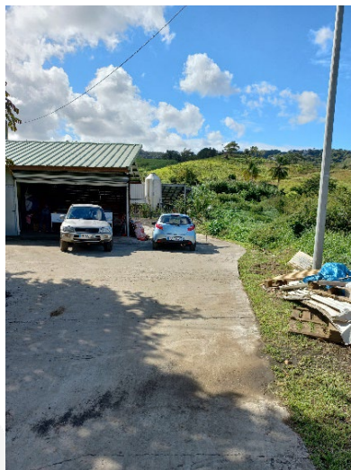
Figure 10 : Places de stationnement sur une zone du site
