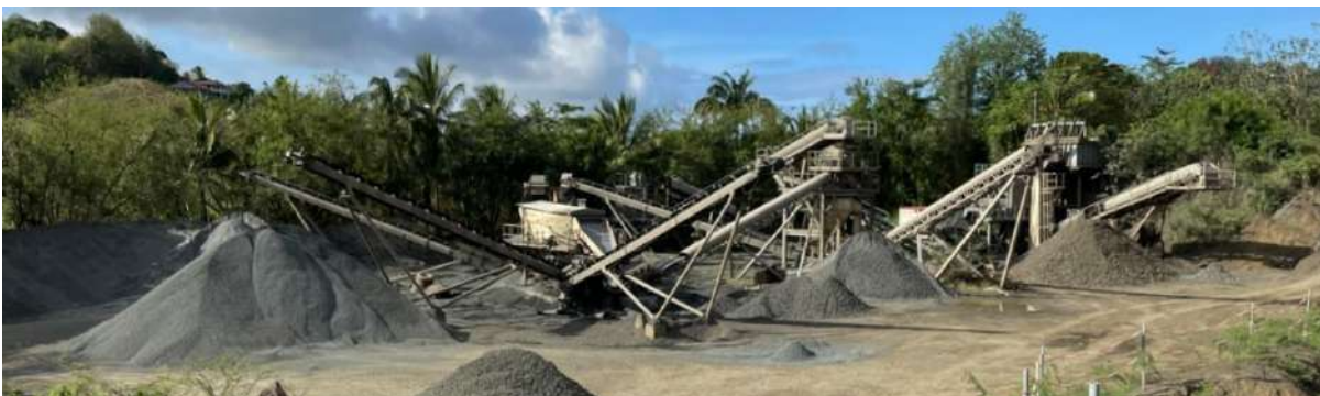
Figure 17. Installations de traitement (SMDG, juin 2023)
