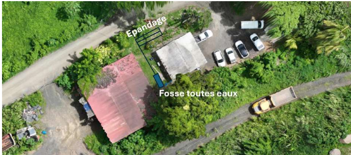
Figure 64. Système d'assainissement non collectif du site
