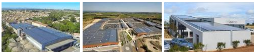
Figure 9 : Centrales photovoltaïques en toiture (source : TotalEnergies Renouvelables France, 2023)
