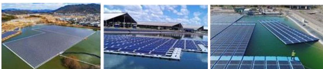
Figure 12 : Centrales photovoltaïques flottantes (sources : Ciel & Terre International (1 et 2), Isifloating (3))
