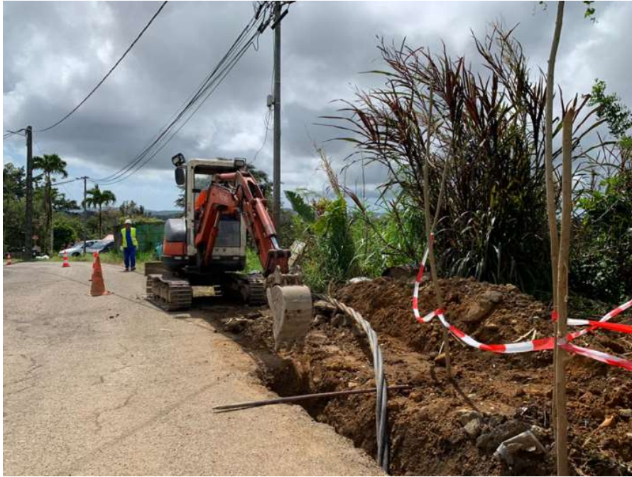
FIGURE 17 : EXEMPLE D'OUVERTURE DE TRANCHEE (SOURCE EDF)
