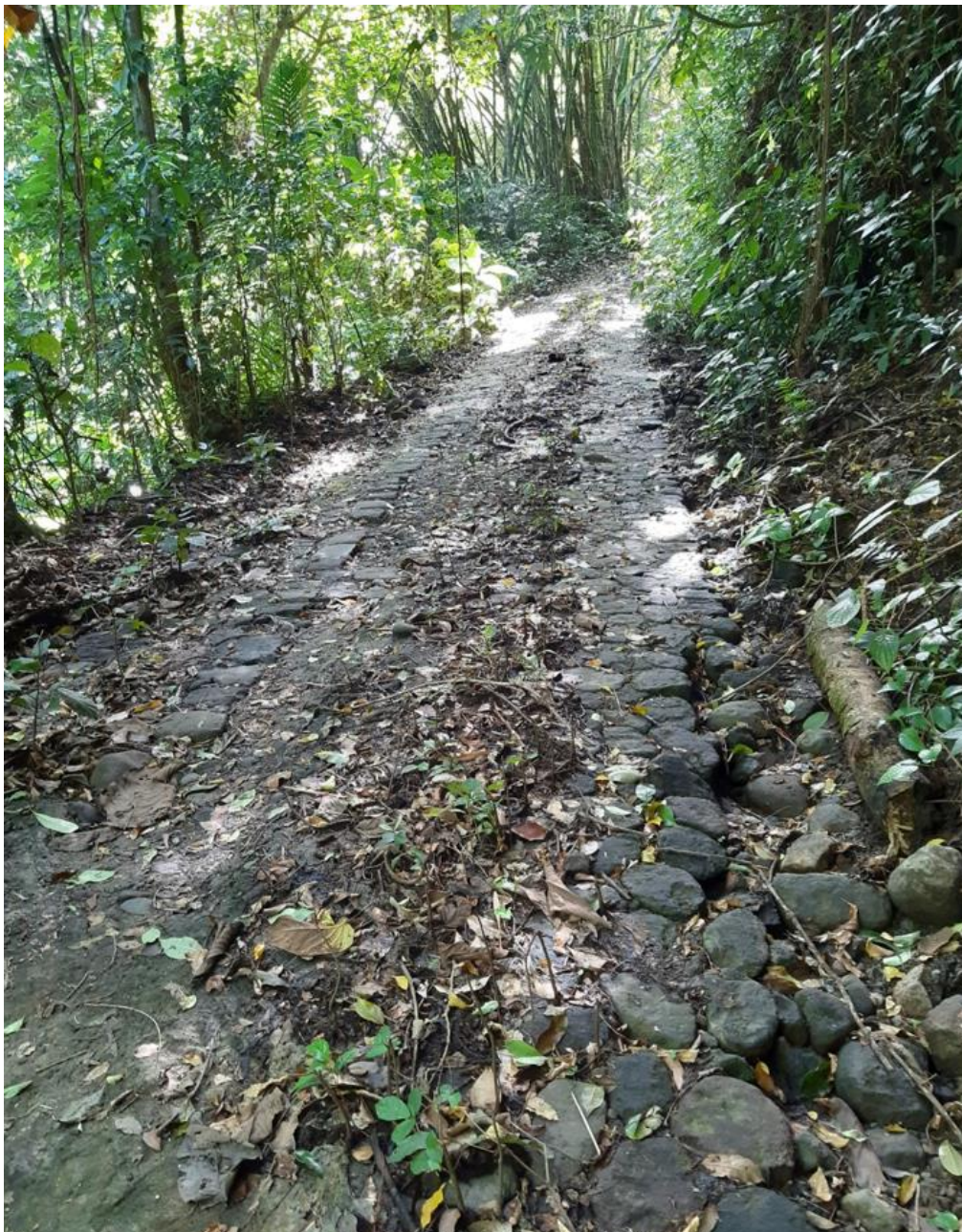
Figure 3 : Vue chemin pavé en remontant sur Beauséjour
