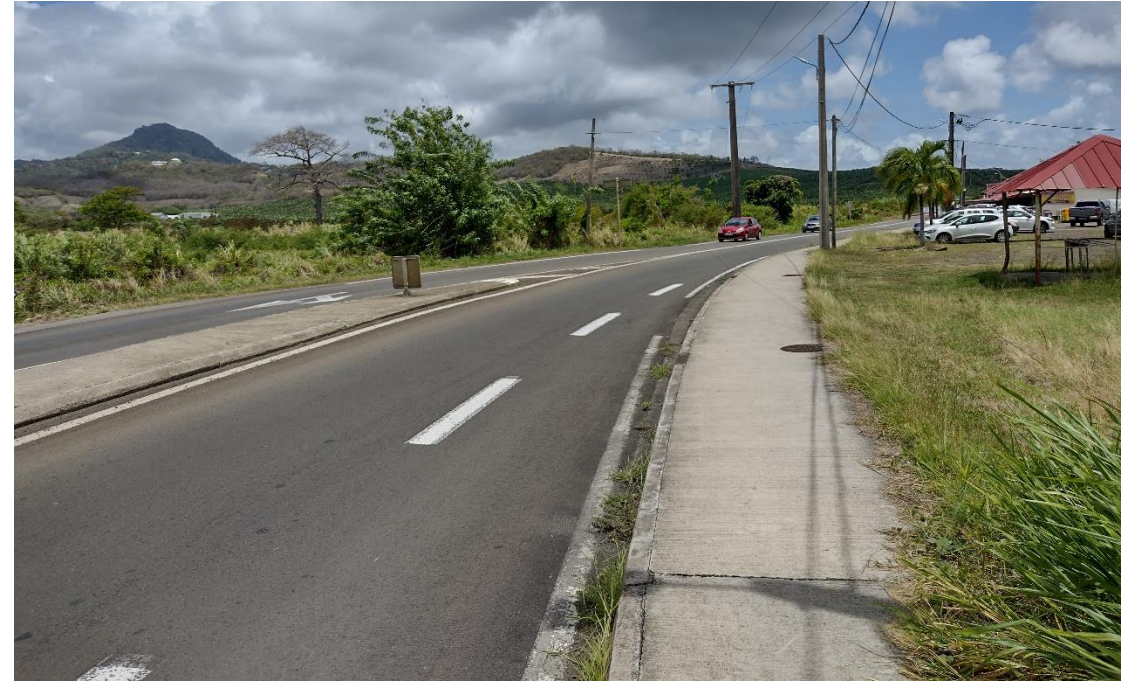
Vue n°3 : la RN6 au droit du site
