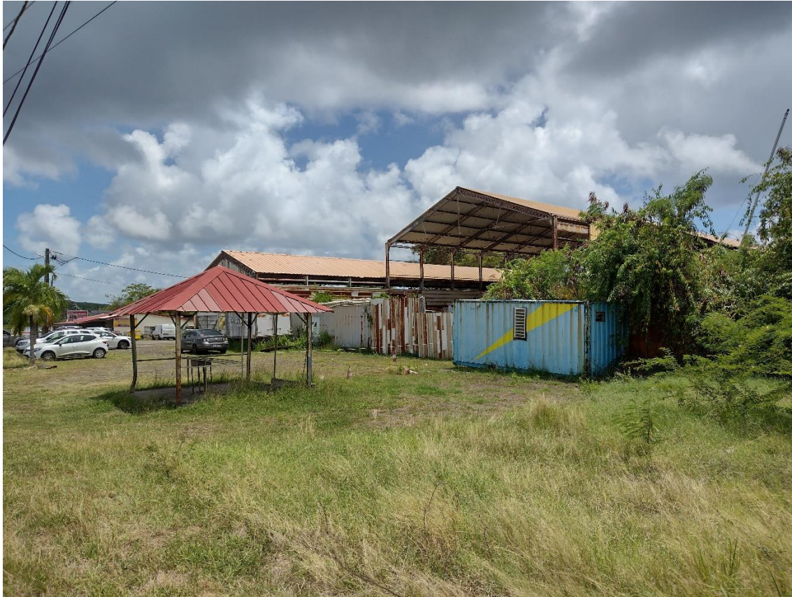
Vue n°1 : vue sur le site depuis le trottoir de la RN6
