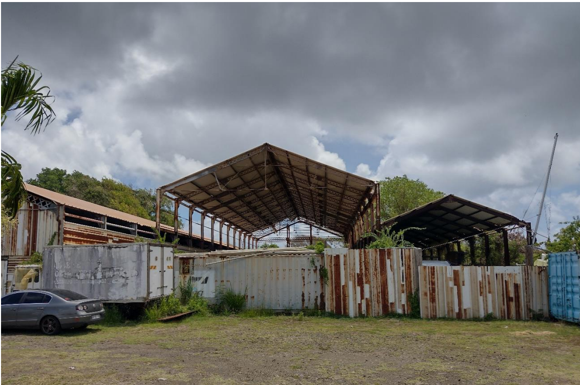
Vue n°2 : zoom sur l'usine et hangars du site
