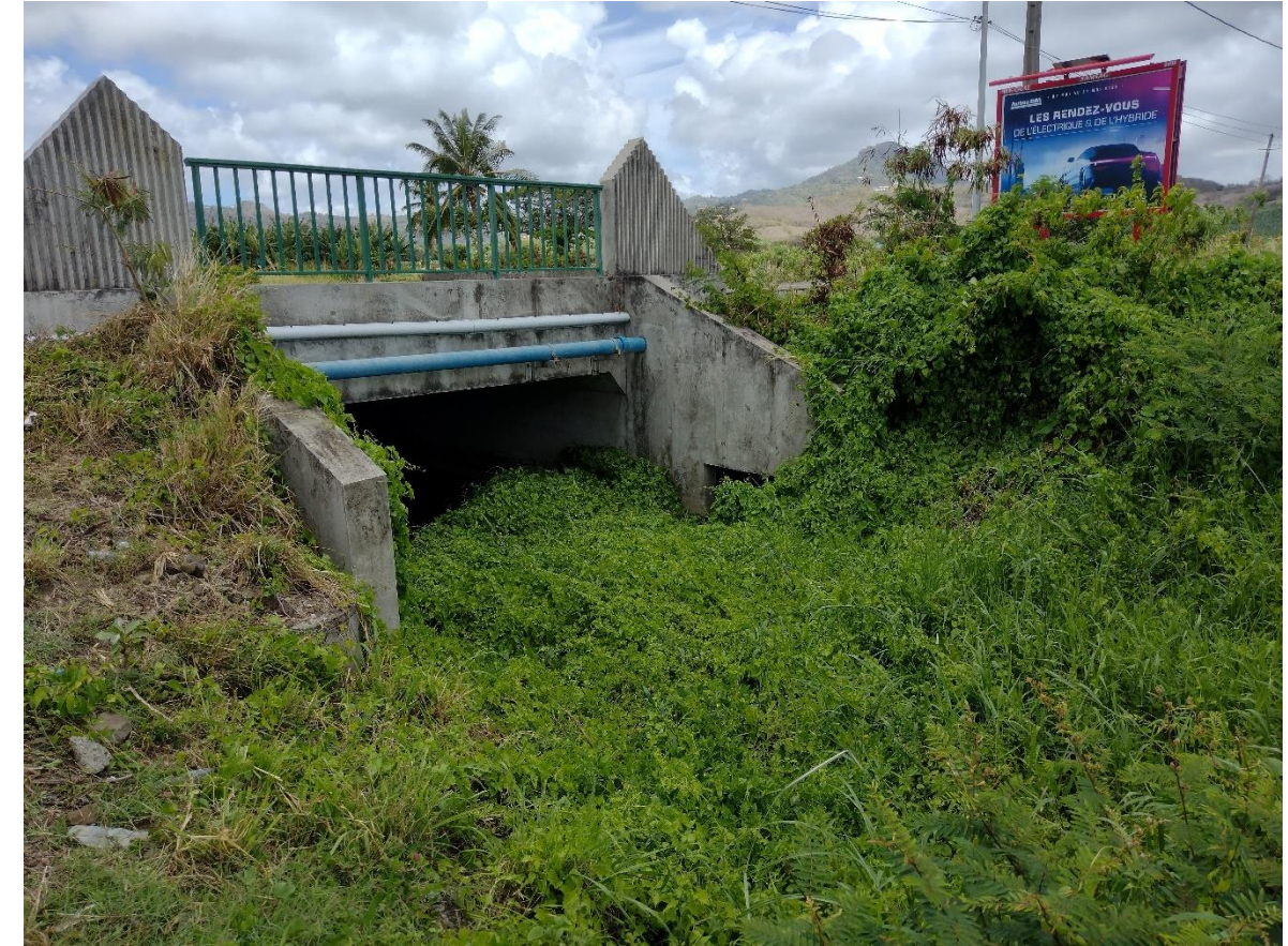
Vue n°9 : ouvrage de franchissement de la RN6 de la ravine
