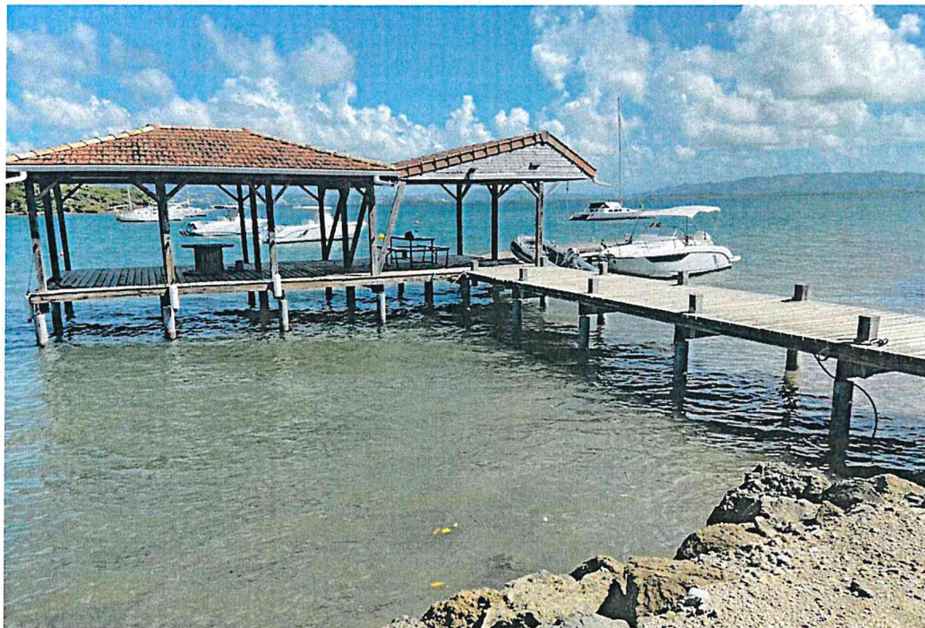
Photo 1 : Vue du ponton existant depuis la partie terrestre. (T. Voyer 2022)
