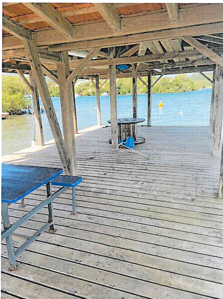
Photo 4 : Vue depuis ponton existant (T. Voyer 2022)
