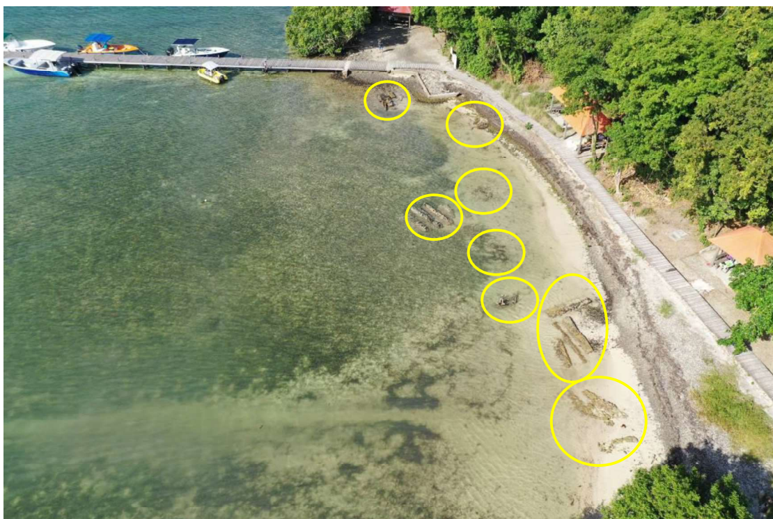
Figure 1 : Identification des tronçons de muret à évacuer sur la zone de chantier 1/3
