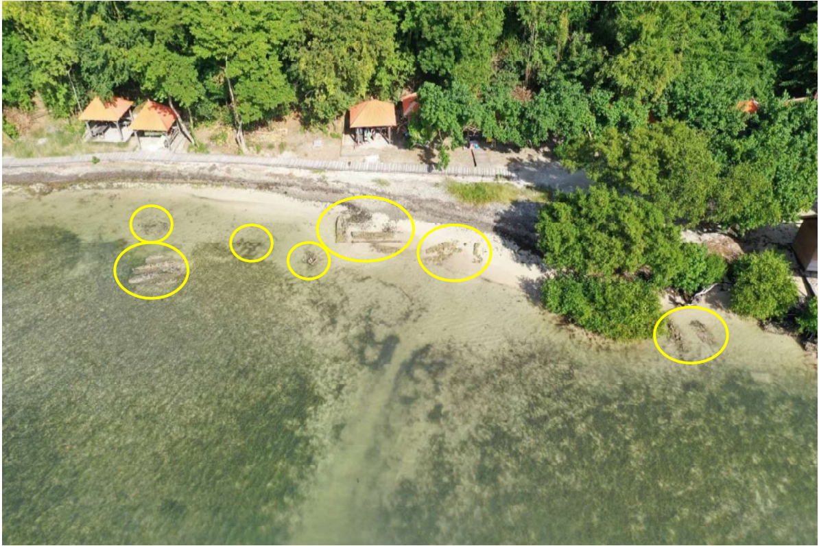
Figure 2 : Identification des tronçons de muret à évacuer sur la zone de chantier 2/3
