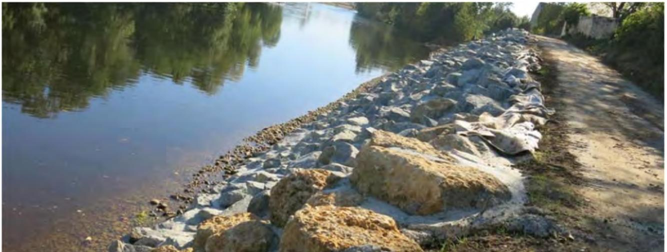
Exemple d'enrochements bétonnés
