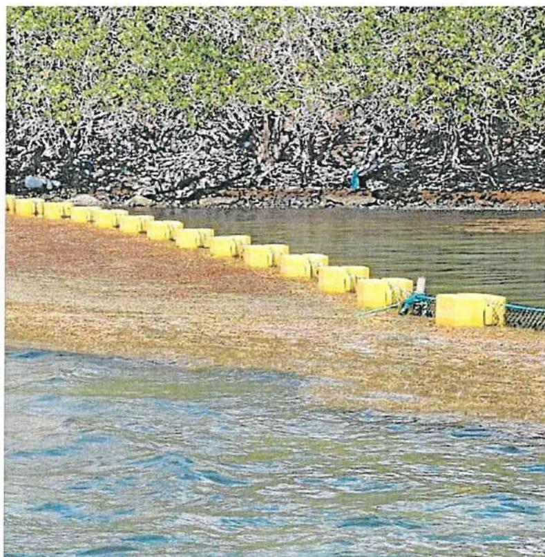
Figure 7 : Exemples de filets disposés devant le littoral permettant de stopper les algues (Source FILET DROM)
