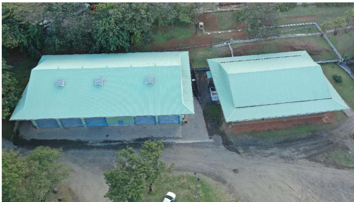
Vue aérienne : Projet chai inox 2 / chai inox 1 (01/02/2022)
