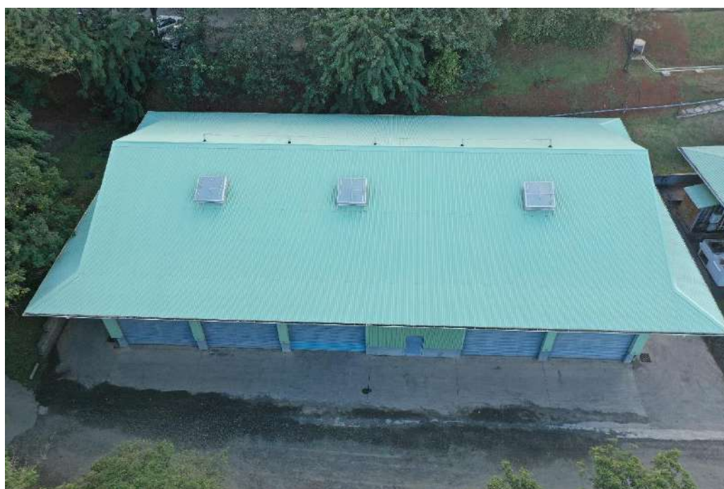
Vue aérienne Projet chai inox 2 (01/02/2022)
