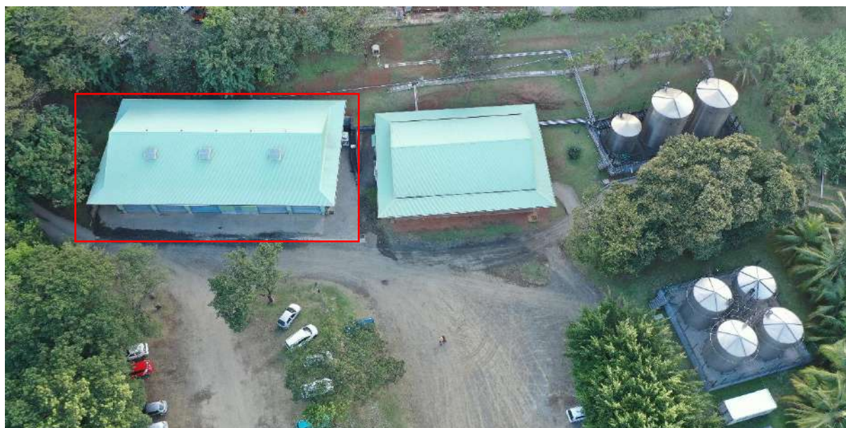
Vue aérienne : Projet Chai inox 2 / Chai inox 1 / Cuveries extérieures de réception (01/02/2022)
