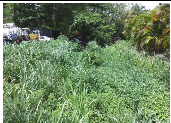
Prise de vue 6 Zone aval en direction de l'exutoire vers la baie. Présence de végétation ne permettant pas un
