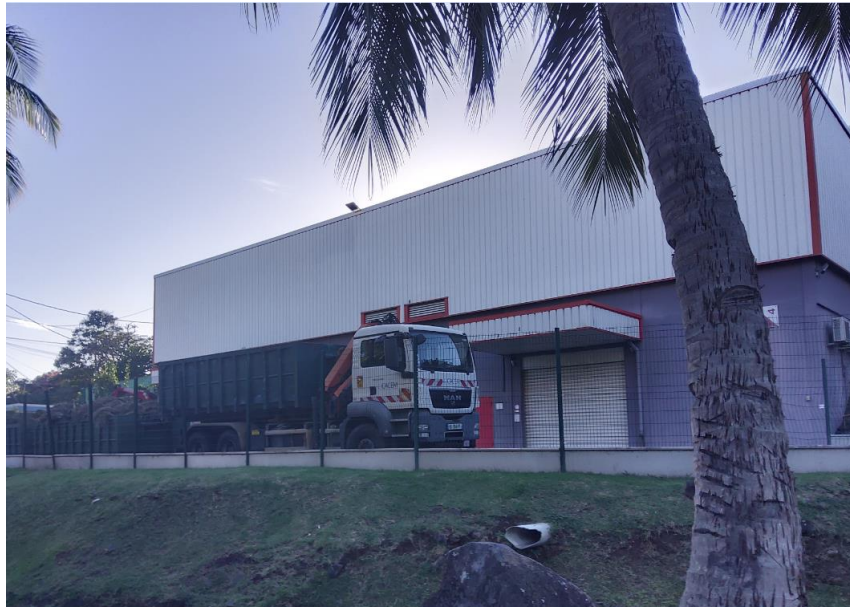
Figure 5 : Zone industrielle et commerciale à l'ouest de la zone d'étude - Prise de vue n°5
