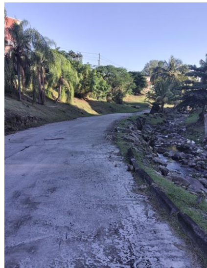
Prise de vue 4 : Ravine et voie d'accès
