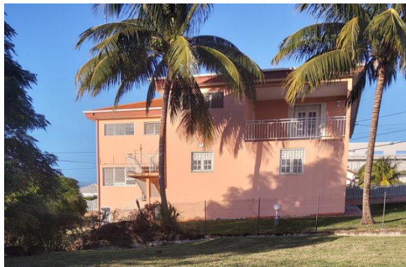
Figure 4 : Zone résidentielle à l'est (Source : Suez Consulting, janvier 2021) - Prise de vue n°3 et 4
