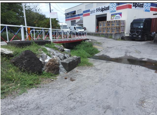
Prise de vue 5 : Deuxième pont Zone de stockage des eaux de ruissellement
