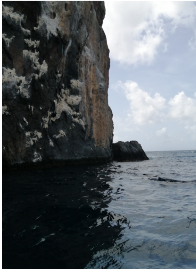
FIGURE 3 - SITE DE LA FAILLE - JUILLET 2021
