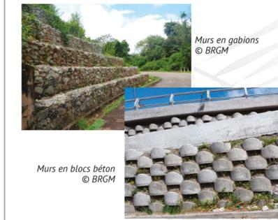
Un mur de soutènement n'est pas un simple mur... C'est un ouvrage complexe qui s'adapte à chaque situation : à la nature des sols, au relief, à la présence d'eau dans les terrains, ... Il doit donc être conçu et réalisé par des professionnels.
