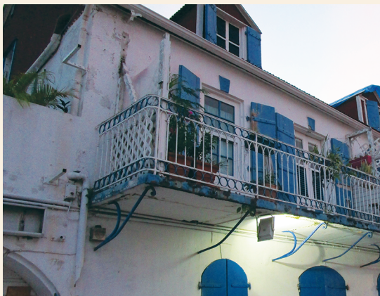
Figure 1 : Volets opaques ayant assuré une bonne protection
