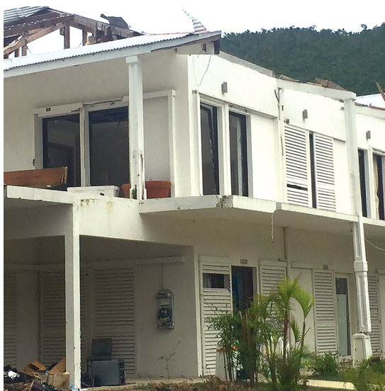
Figure 3 : Fixation insuffisante des volets
