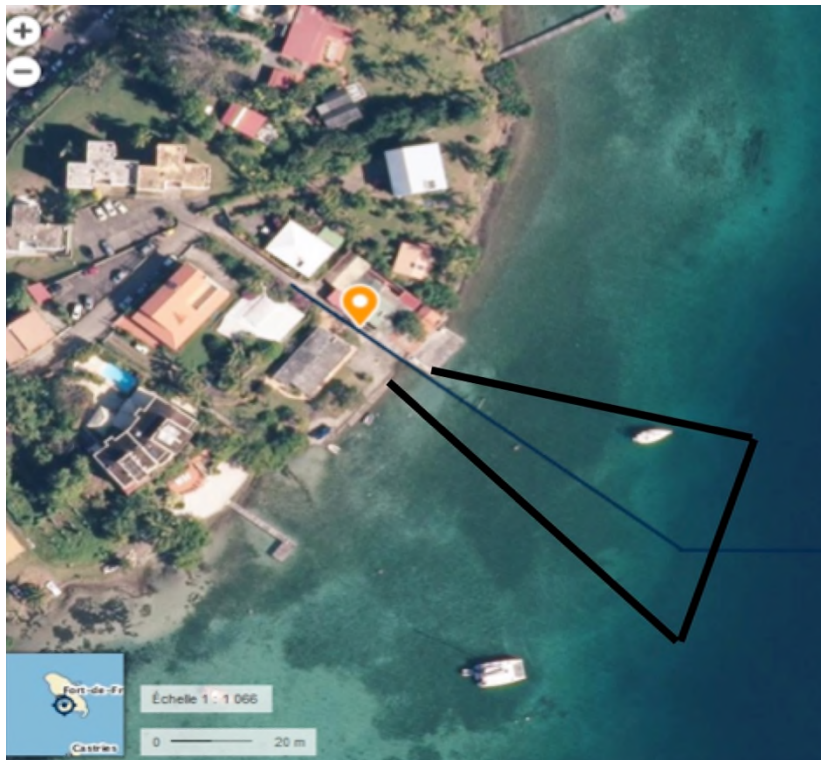
Figure 23. Zone d'atterrage des câbles au niveau de la Pointe du Bout aux Trois-Ilets (Source : EDF)
