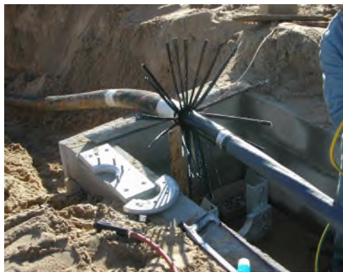
FIGURE 36 ILLUSTRATION DE LA JONCTION DU CÂBLE SOUS-MARIN ET SOUTERRAIN
