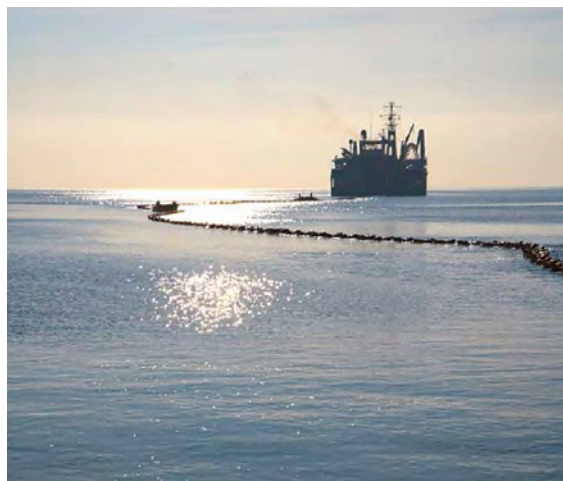
FIGURE 29 TYPE DE NAVIRE CÂBLIER ET POSITIONNEMENT D'UN CÂBLE SUR FLOTTEUR AVANT IMMERSION
