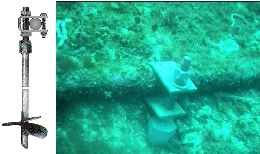
FIGURE 28 SCHÉMA ET ILLUSTRATION D'UTILISATION D'UN COLLIER POUR FIXER LES CÂBLES AUX ANCRES
