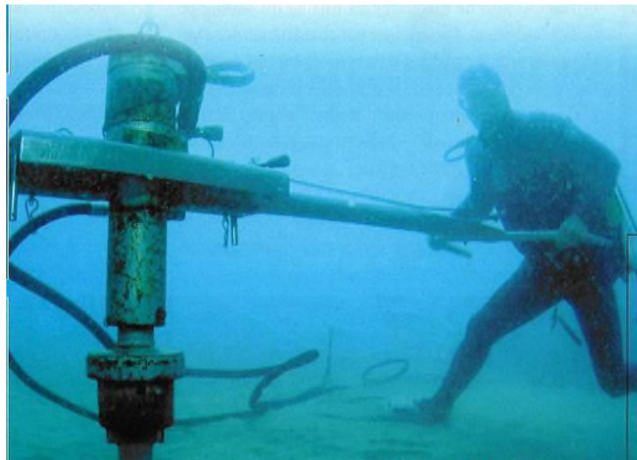
FIGURE 26 ILLUSTRATION D'UNE CLÉ HYDRAULIQUE UTILISÉE POUR VISSER LES ANCRAGES
