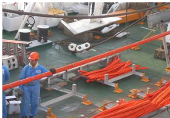
FIGURE 31 : EXEMPLE DE CÂBLE PROTÉGÉ
