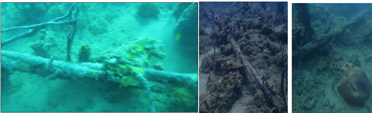
Figure 21 Observation in-situ du câble existant dans le franchissement d'une zone indurée (source Impact Mer 2020)
