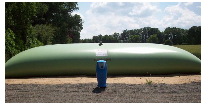
Figure 20 - Exemple d'une citerne souple d'une installation photovoltaïque
