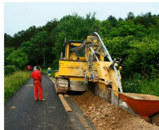
Figure 16 : Illustration de la pose de câbles électriques en souterrain au moyen d'une trancheuse. Source : Site internet de l'entreprise TATTU T.P.
