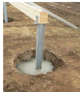
Photographie 4 : Fondation béton (à gauche) ; fondation vis (à droite)
