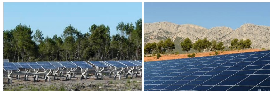
Photographie 1 : Structures solaires (à gauche: les trackers de la centrale de Gabardan (40) qui suivent le soleil ; à droite : structures fixes à Puylobier (13)) - Source : EDF RENEUVELABLES
