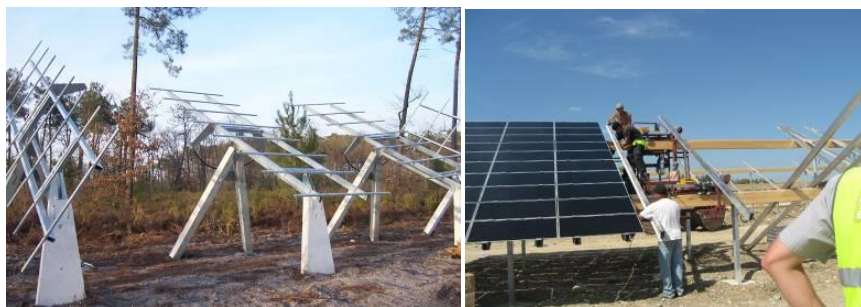
Photographie 5 : Montage des supports de la technologie « trackers » (à gauche), montage de modules sur des supports fixes (à droite)
