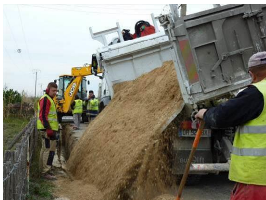
Figure 17 : Illustration d'un autre mode de recouvrement des tranchées. Source : BIOTOPE
