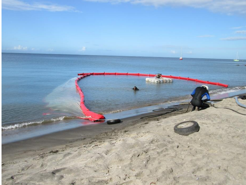
Figure 31: Barrage de confinement utilisé ici dans le cadre de l'ensouillage du câble Kanawa en 2018 (Orange)
