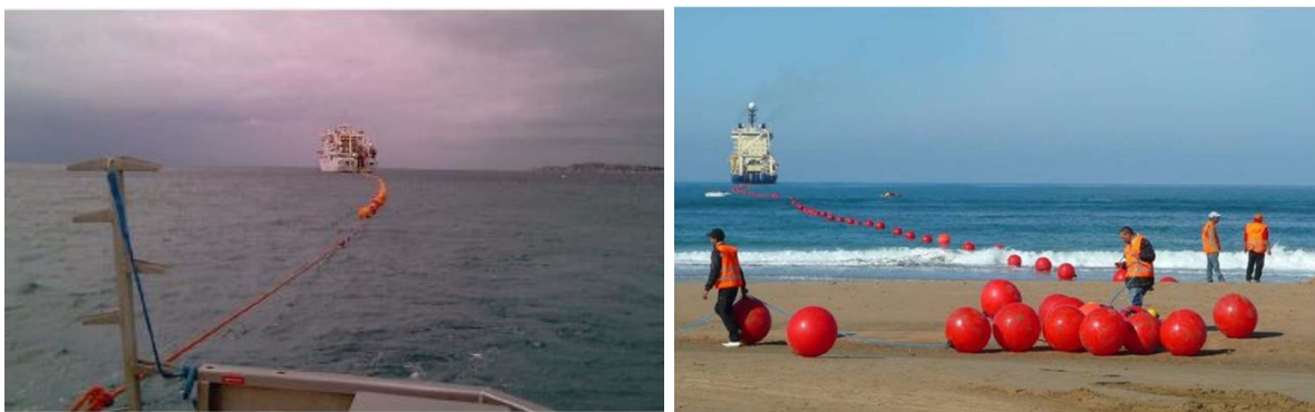
Figure 22 : Exemple de tirage d'un câble flotté, ici depuis un navire câblé vers la plage (Orange Marine) (à gauche) et câble en flottaison à l'aide de flotteurs (à droite) (ASN)
