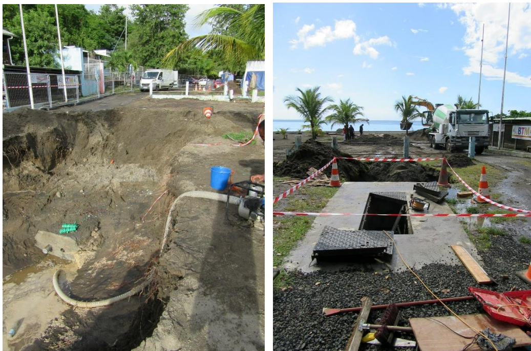
Figure 21 : Entrée des conduites (à gauche) menant à la chambre-plage (à droite) (photos des travaux dans le cadre du projet Kanawa)
