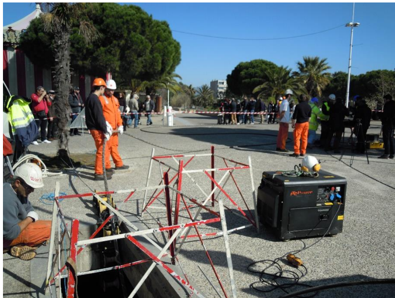
Figure 25 : Tirage du câble en dehors de la chambre plage avant raccordement
