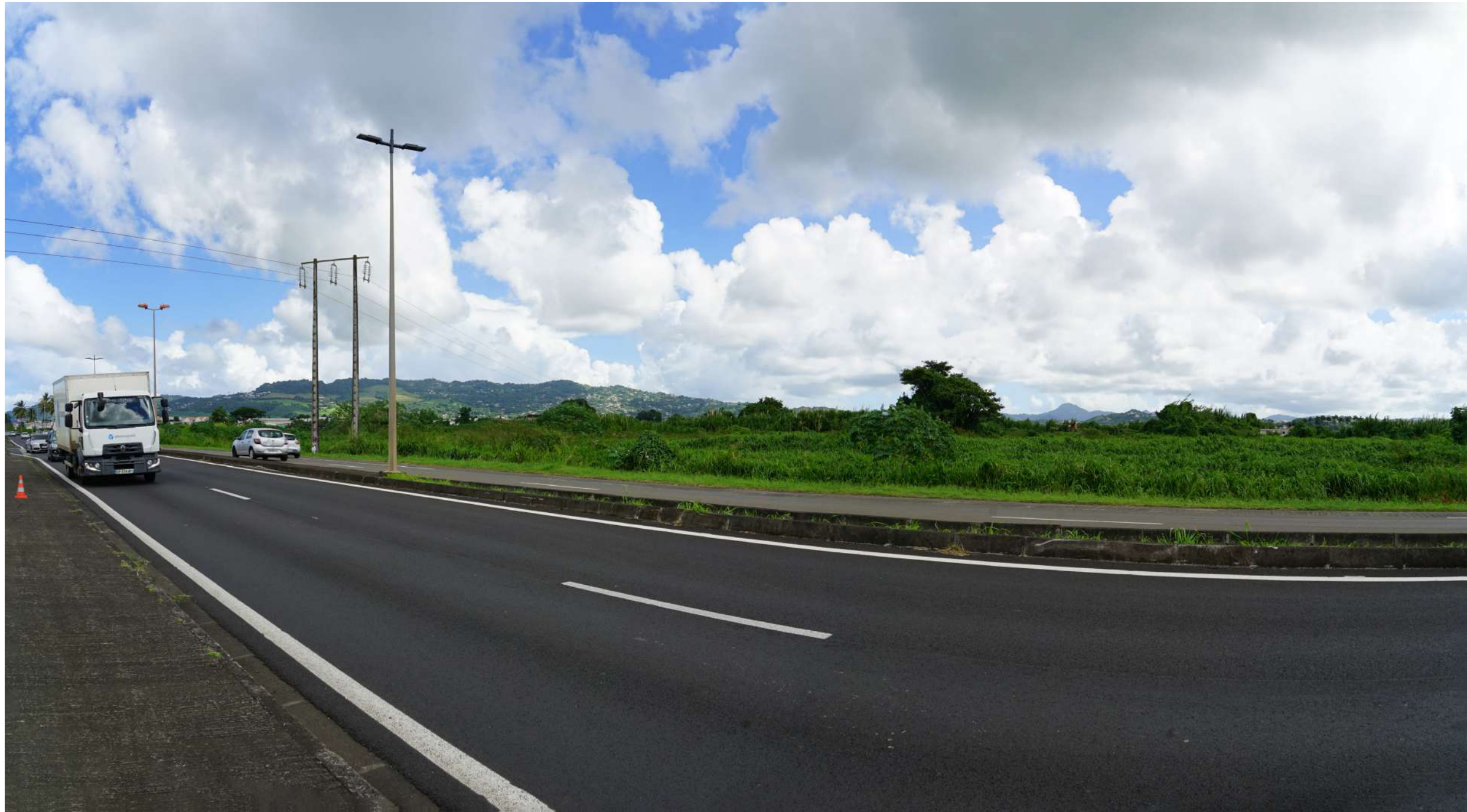
Point de vue n°4 : Point de vue depuis le nord de la RD3 - Etat initial
