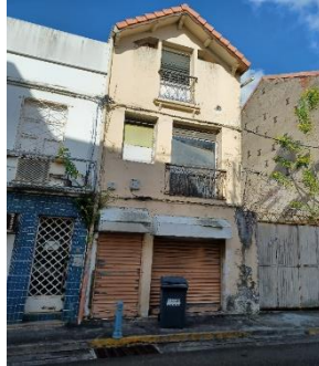
Immeuble avec local commercial à l'abandon
