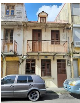
Immeuble de type R+1 avec combles aménagées – Rue Perrinon
