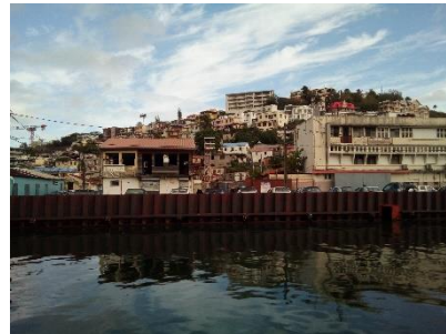
Friche urbaine (caserne + pompe funèbre) - canal Levassor
