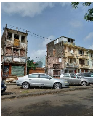
Façades dégradées sur carrefour parc Aimé Césaire
