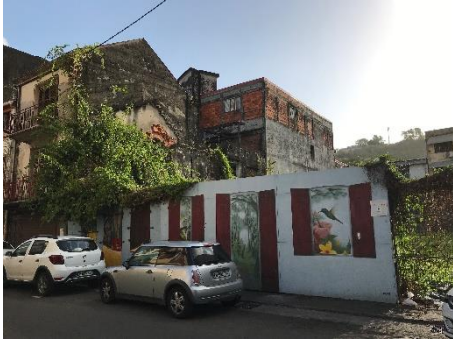
Ilot Dib Notte – Façade cœur d’îlot sur Rue Arago
