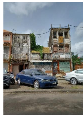
Ensemble de bâtis proches de la ruine.
