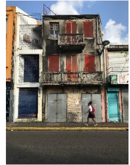
Immeuble dégradé à côté d’un commerce face au marché aux poissons
