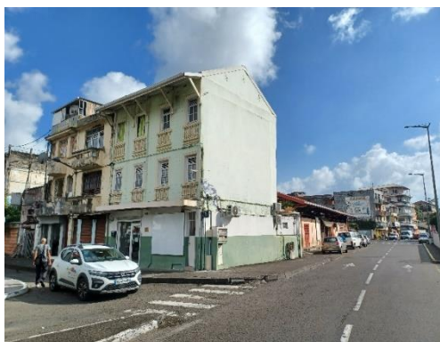
Façade sur l'angle Nord-Ouest - Avenue Paul Nardal
