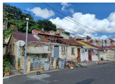
Habitats individuels en très mauvais état dégradé - Gueydon Nord
