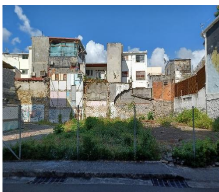
Parcelles nues clôturées, constructions entièrement démolies - Rue Lazare Carnot
