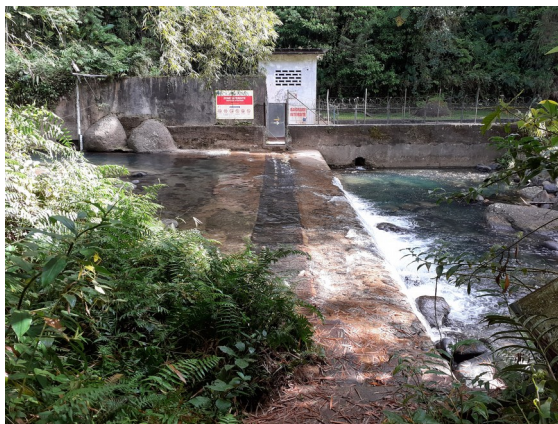
Vue du seuil de prise d'eau et dessableur
