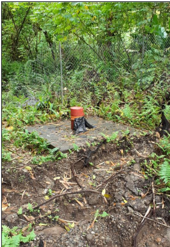
Figure 36 : Tête de l'ouvrage CBF1 (Source : SUEZ Consulting)
