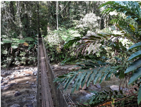
Passerelle piétonne en amont des forages
