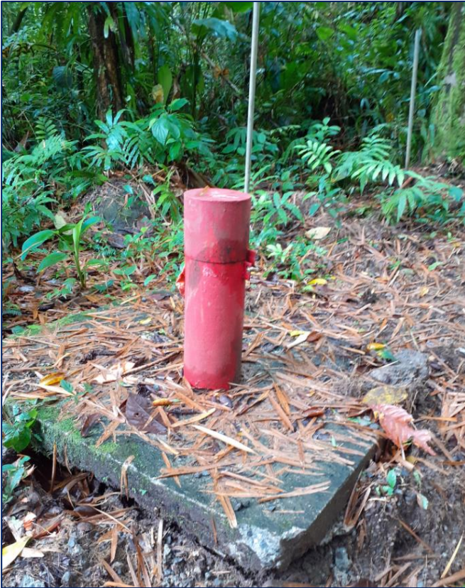
Figure 39 : Tête de l'ouvrage CBF2 (Source : SUEZ Consulting)
