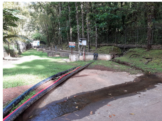
Vue du dessableur et des conduites de refoulement des forages installées en 2020
