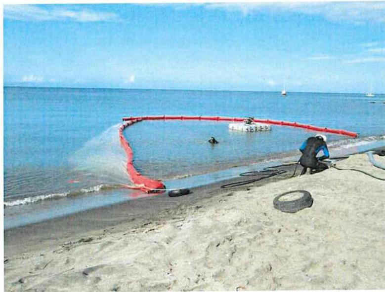
Figure 31: Barrage de confinement utilisé ici dans le cadre de l'ensouillage du câble Kanawa en 2018 (Orange)
