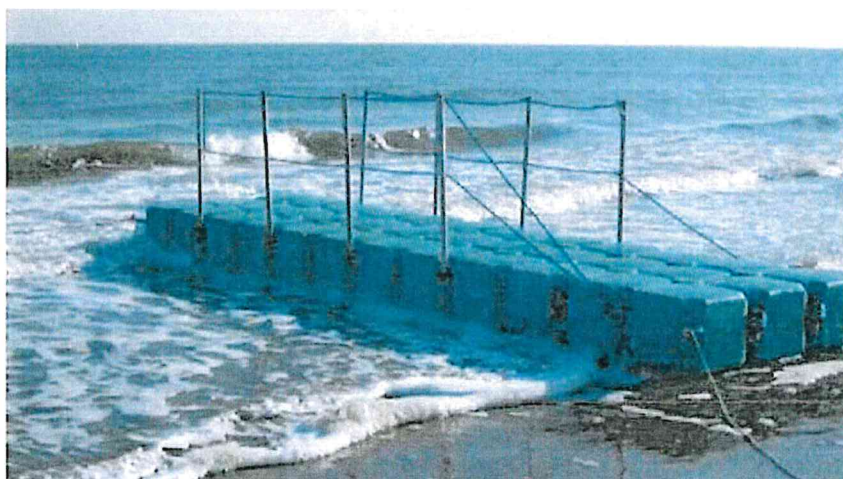
Figure 5 : Amarrage inapproprié des annexes sur les appontements à passagers
