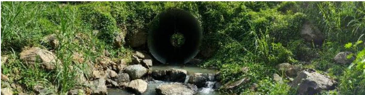
Figure 44. Photo des enrochements végétalisés en aval de l'ouvrage n°4 - Mars 2018.
