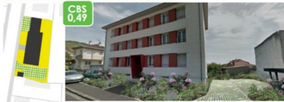
TEST 2 : TRAITEMENT DES EXTÉRIEURS UNIQUEMENT
