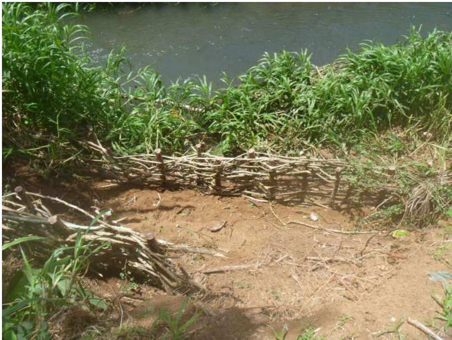
Opération de stabilisation des berges de la rivière du Galion par génie végétal – Photo ODE 2016
