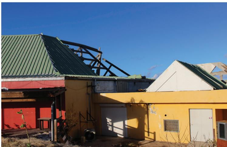
*Figure 5 : Charpente mal contreventée*
