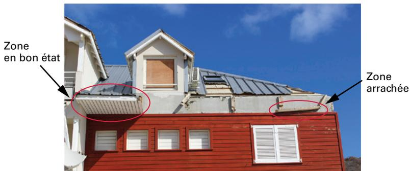
Figure 4 : Débord de toiture sous-dimensionné
