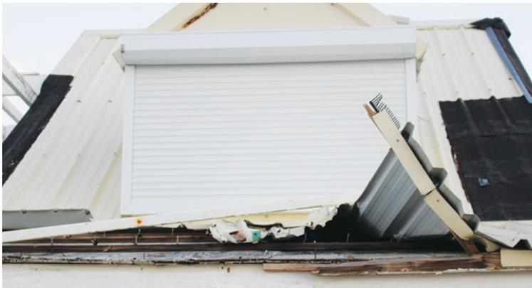
Figure 3 : Liteau de section trop faible et/ou trop peu fixé
