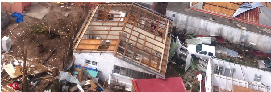
Figure 4 : Absence de contreventement
