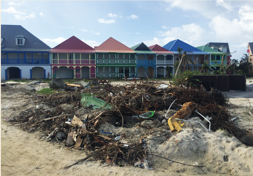
Figure 1 : Charpentes en site exposé ayant résisté
