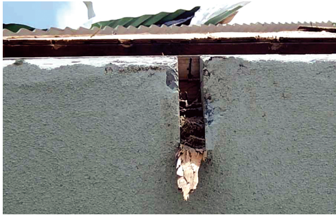
Figure 10 : Mauvaise fixation de la charpente au chaînage
