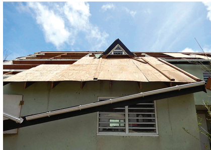
Figure 3 : Espacement des pannes trop important
