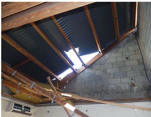
Figure 6 : Mauvaise fixation des tôles aux pannes
