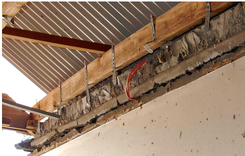
Figure 11 : Mauvaise fixation (plats mal ancrés)
