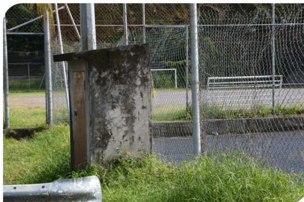
Voie accès poste électrique (Pont de Chaines) ©D. Joseph-Reinette (DEAL972)
