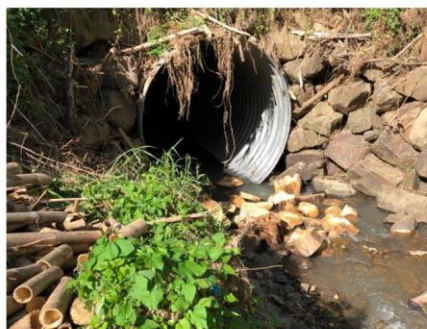
Création de l'ouvrage 5 – accès site industriel, gestion de crue et des embâcles.
