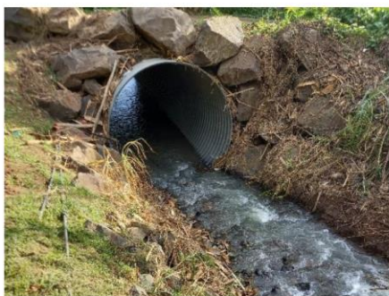
Redimensionnement ouvrage 4 – gestion des crues et correction des discontinuités.
