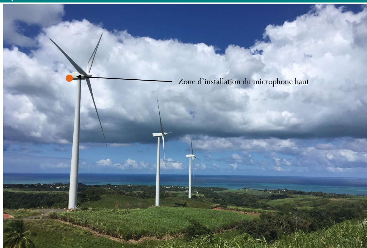
Figure 8. Illustration d'un microphone SMM-U2 déporté en nacelle
