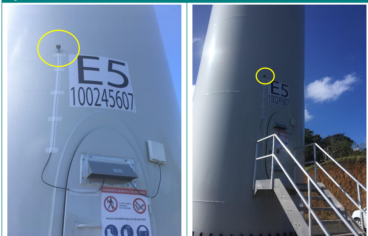
Figure 9. Illustration d'un microphone SMM-U2 déporté en pied de mat
