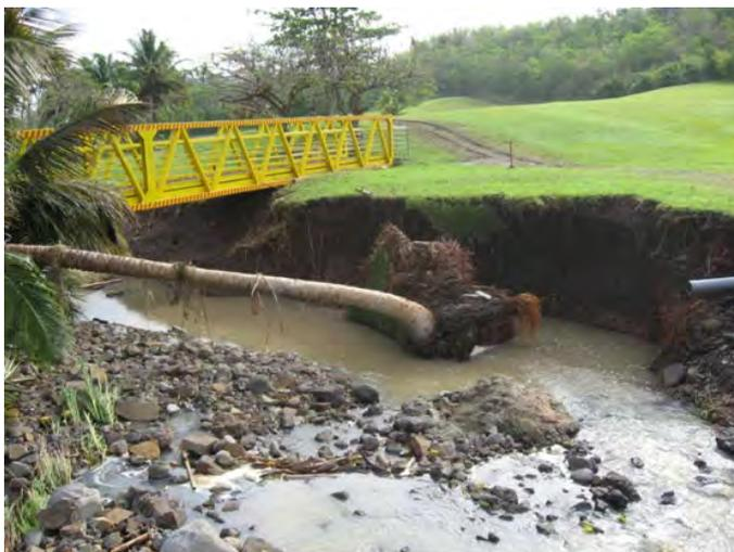
Brèche du barrage de fermeture du bassin de rétention N°1
