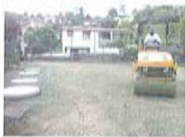
École Morne Acajou Travaux effectués en 2011 Nombre de eh : 105
