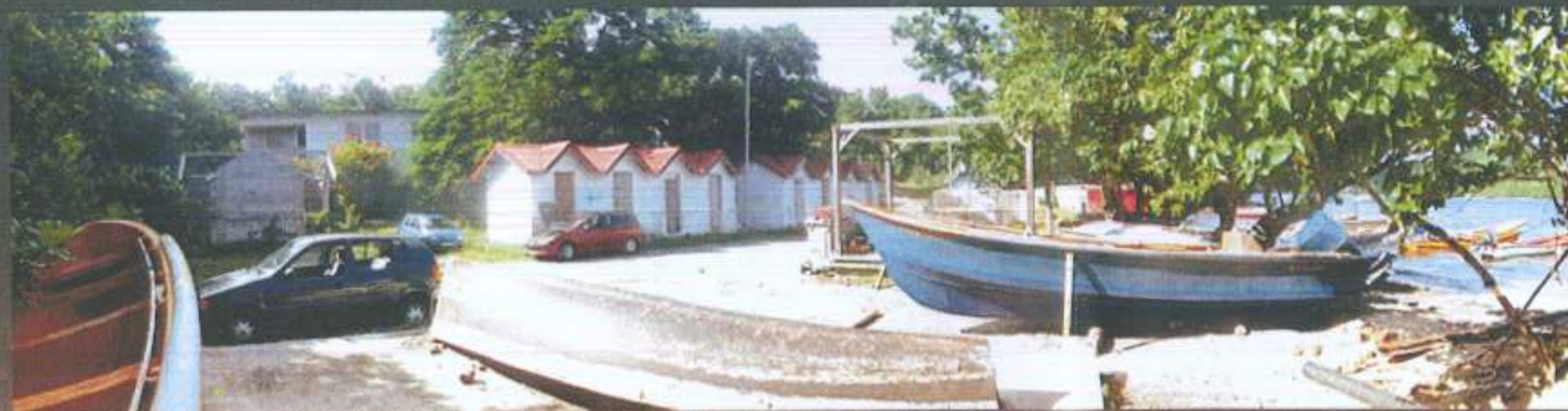
Vue à partir bord de mer vers cabanes pêcheurs à démolir et anciens bungalows à réhabiliter
