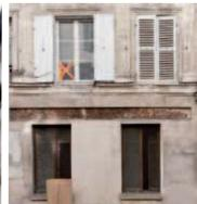
Le diagnostic de ces éléments doit porter sur la sécurité (bonne fixation ou ancrage des composants pour éviter toute chute sur la voie publique) et sur le niveau de dégradation empêchant leur fonctionnement ou provoquant des dégradations sur le bâti : état et qualité des protections des bandeaux ou corniches pour assurer l'évacuation de l'eau, état des canalisations pour éviter les infiltrations dans les murs et les logements, état des menuiseries en terme d'étanchéité à l'air et à l'eau....
